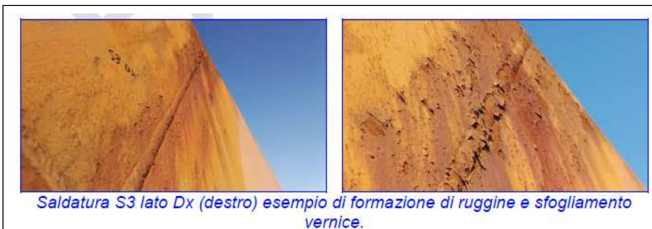
Figura 10: Corrosione localizzate carpenterie
