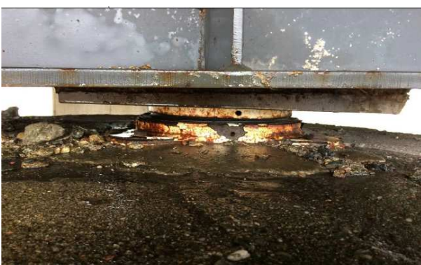
Figura 8: Degrado degli appoggi più ammalorati
