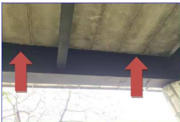
Foto 11 e Foto 12 – Spessore anomalo tra soletta e trave: Stocchi di legno e riempimenti di cls
