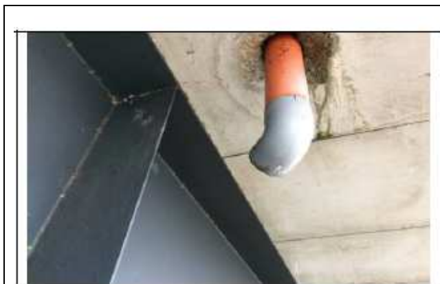
Figura 13: Pluviale dannoso: si noti la presenza di percolazioni all'attacco con la soletta
