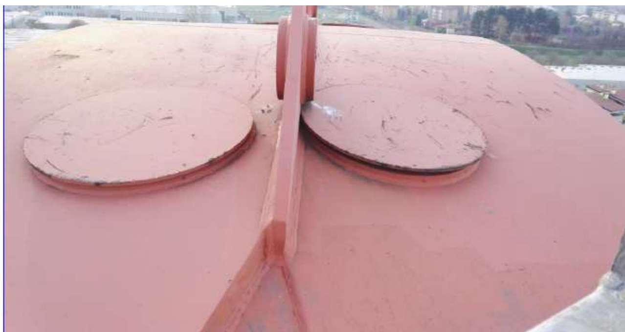
Tappi di accesso teste di ancoraggio stralli
