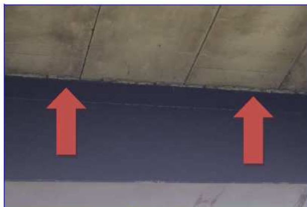
Foto 11 e Foto 12 – Spessore anomalo tra soletta e trave: Stocchi di legno e riempimenti di cls
