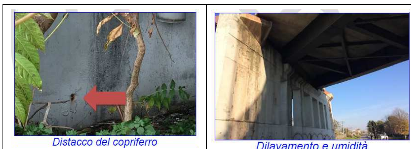
Figura 1: Patologie da ripristinare tramite interventi corticali
