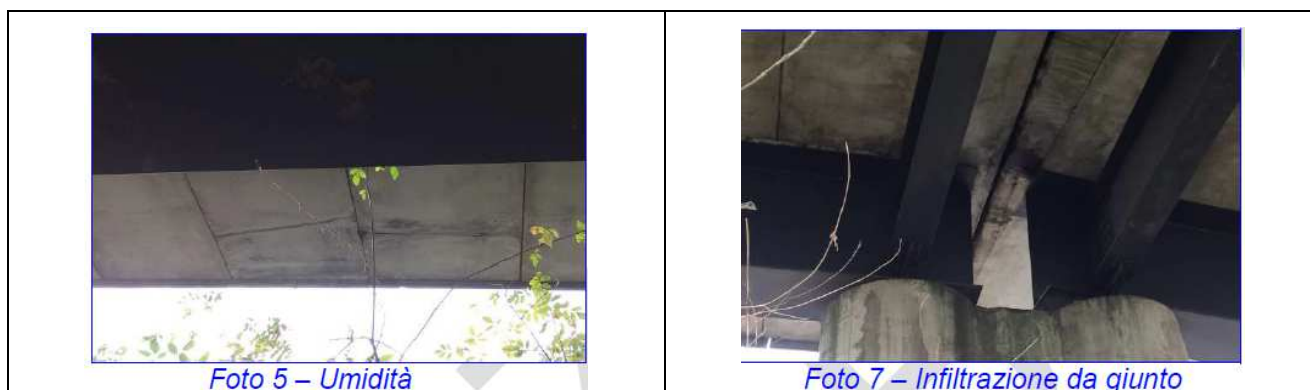
Figura 5: Immagini della difettosità /2
