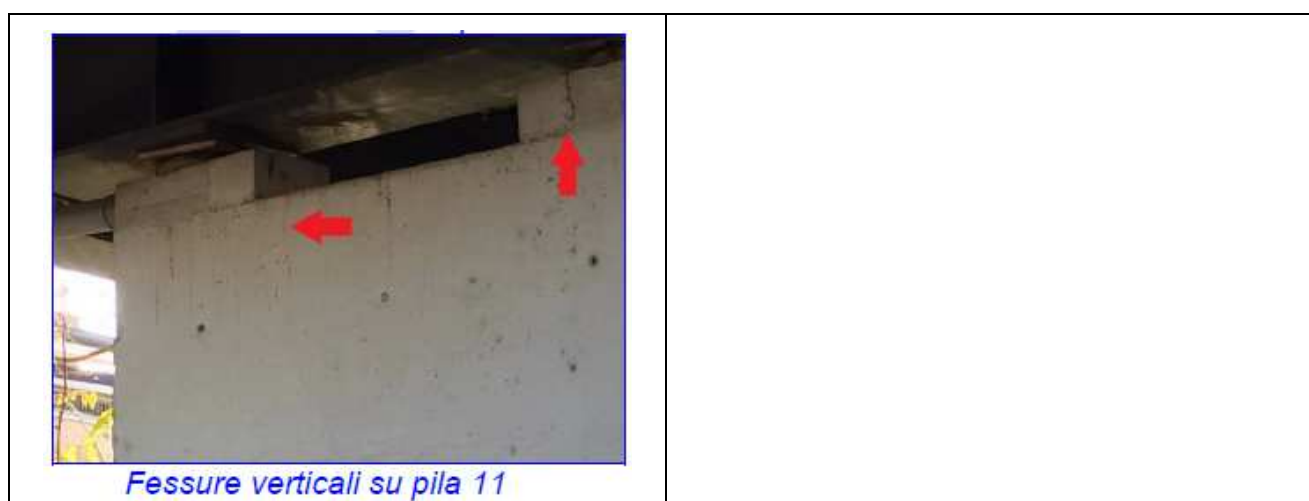
Figura 3: Fessurazioni su testa pile/spalle viadotto
