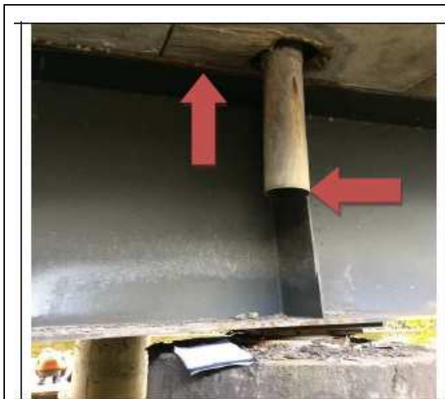
Figura 12: Pluviale mancante che scarica sulla trave e sull'appoggio
